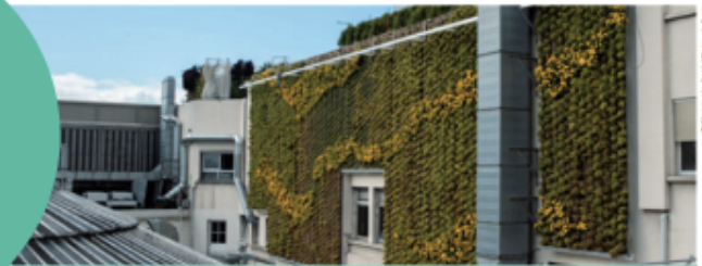
Toit des Galeries Lafayette Haussmann, 9 e / Réalisation Paris
