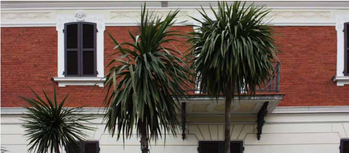
I VILLINE DEL QUARTIERE RESIDENZIALE TRA PIAZZALE GRAMSCI E LE EX-PADANE
